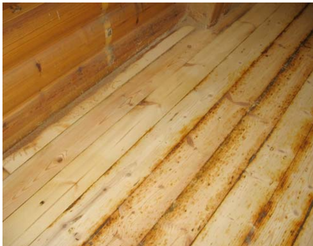
"Ämmäriivin" korkojen jälkiä lattiassa. (Penkit on irrotettu työn helpottamiseksi).
