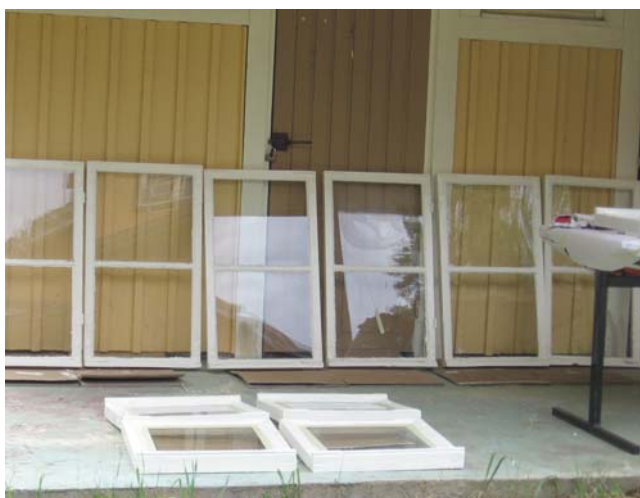
Ikkunat maalauksessa ja kittauksessa.
